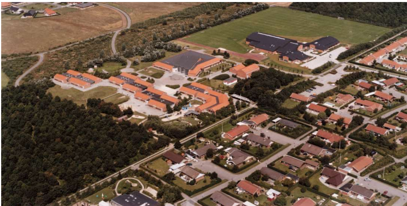
Lufffoto af Sønderriisskolen med naboen Sønderriis Multicenter. Elevtallet på Sønderriisskolen er stødt stigende, og lå i 2022 på 711.
